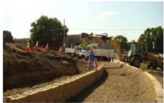
(d) Terraced bioretention cells under construction.
