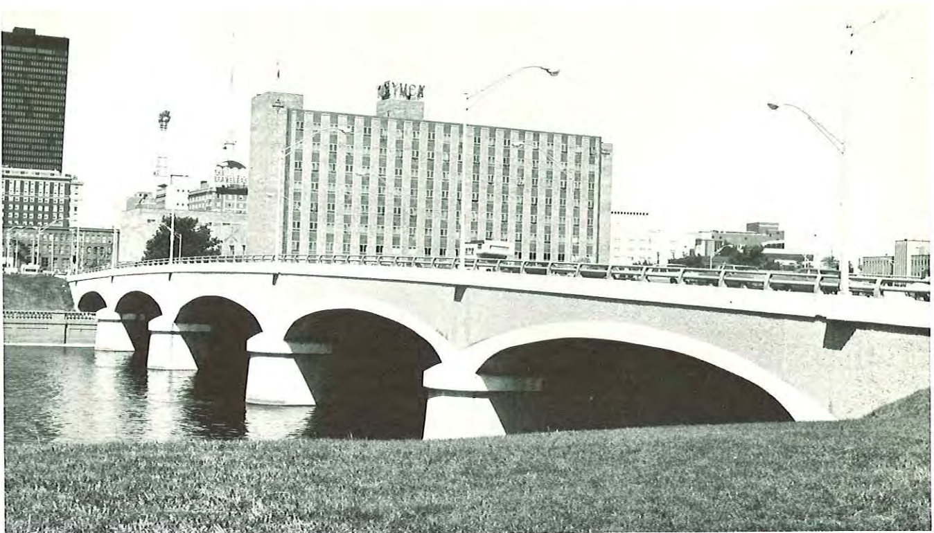
Locust Street Bridge, Des Moines River, Des Moines
